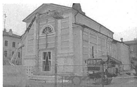
I lavori per il recupero della chiesa di Rovereto di Novi
