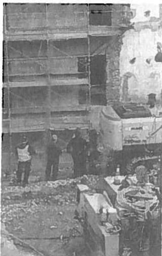
Una cantiera edile
