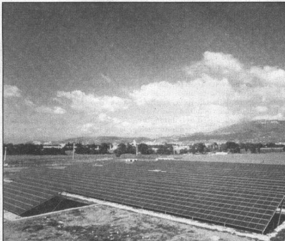
Una centrale a pannelli fotovoltaici
