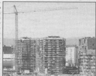
Un cantiere edile
