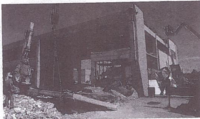
Lavori in un capannone per la ricostruzione
