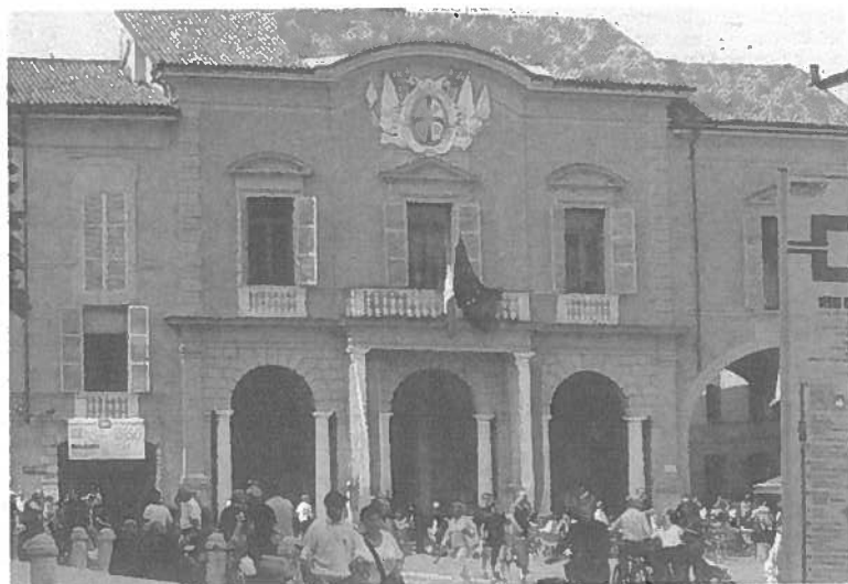
La sede del Municipio di Reggio in piazza Prampolini; in alto, la sede di Cna che ha promosso l'indagine
