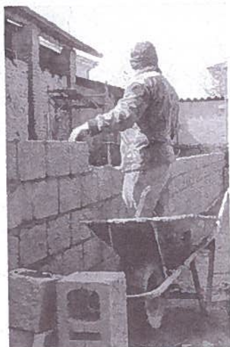
Un cantiere edile
