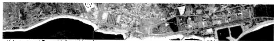
■ Vista d'insieme dell'area di Saline Joniche nel progetto vincitore del premio Portus (vinto da Sudarch nell'ambito della Biennale di Venezia)
