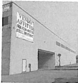
Un capannone in disuso
