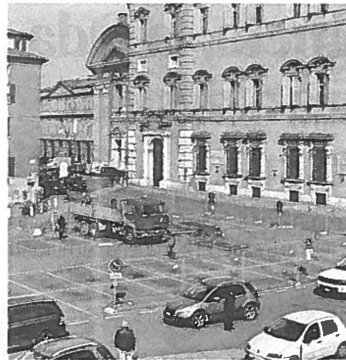
Intanto sono iniziati i lavori in piazza Roma
